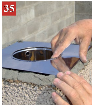
35 A dilatációs hézagtömítő gallért a köpenyelemre felhordott falazóhabarcsba illesztjük, majd újabb habarcsréteget kenünk rá.
