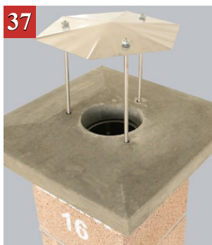
37 Az esővédőt béléscső ragasztóval a fedlapon lévő lyukakba ragasztjuk.
