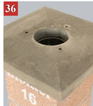
36 A beton fedlapot falazóhabarcs terítékre helyezve a köpenyelemre ragasztjuk.
