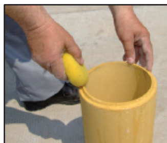
Obe strane šamotne cevi očistimo od prašine.
