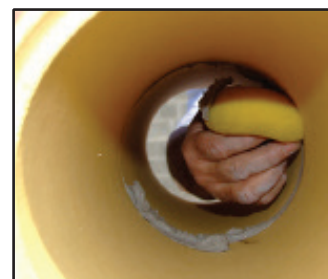
Lepak koji se istisne prilikom spajanja dve cevi sunderom blago izgledimo.
