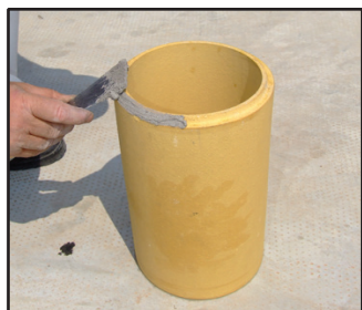
Pripremljen lepak nanosimo na unutrašnje ivice šamotne cevi.
