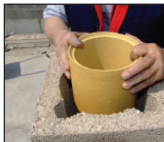
A samott csövet a helyére helyezzük.
